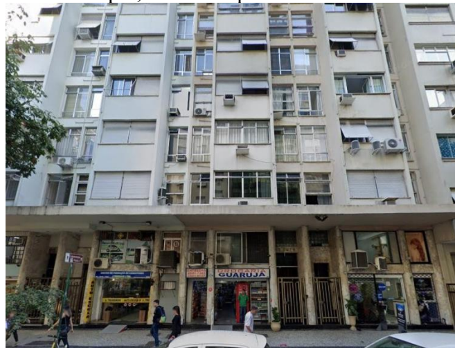
Figura 7: Edifício Chopin, fachada e pilotis laterais atualmente gradeados
